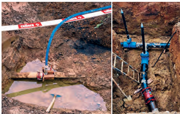
Abb. 8.2.5 und Abb. 8.2.6: Provisorium und neue Schieber
