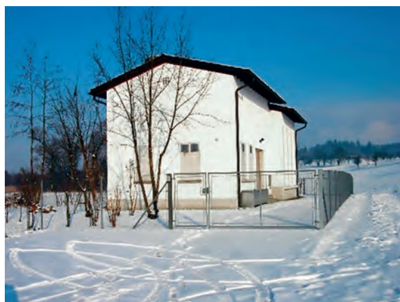
Abb. 8.2.2: Grundwasserpumpwerk mit korrekt umzäunter Schutzzone S1
